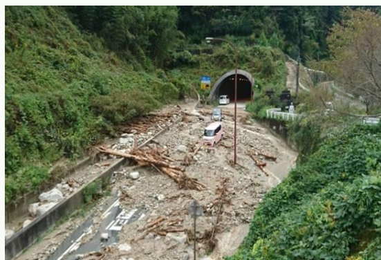
国道 309 号(河南町)
